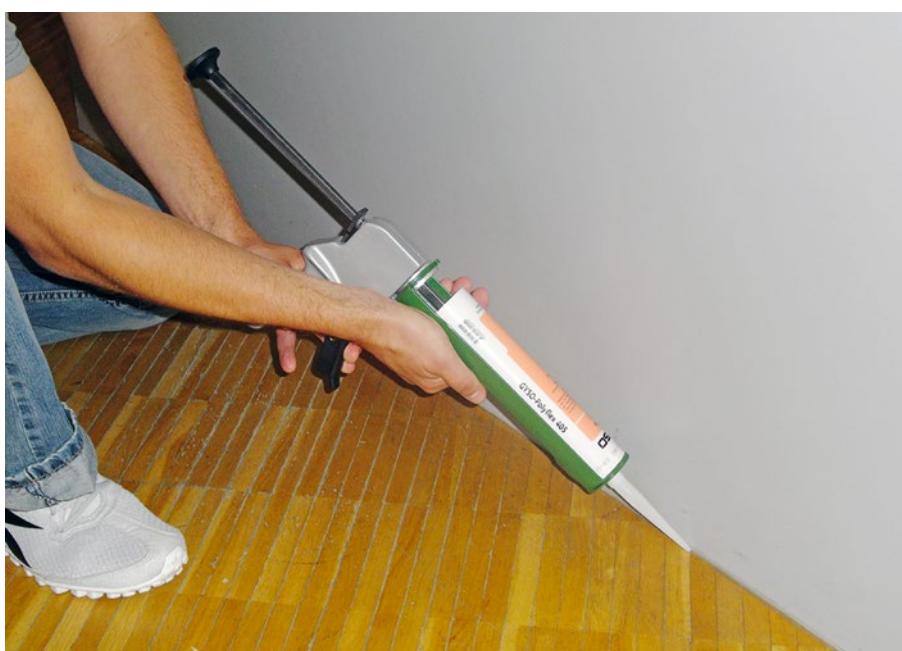
Joint de raccord de parquet dans le domaine intérieur avec GYSO-Polyflex 405
