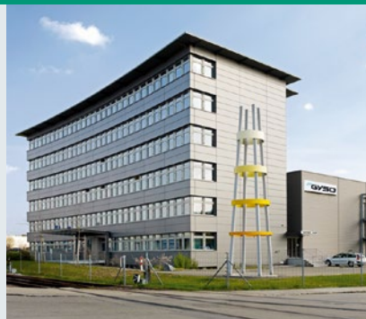
GYSO AG | CH-8302 Kloten Steinackerstrasse 34 Tel. +41 43 255 55 55 Fax +41 43 255 55 65 info@gyso.ch
