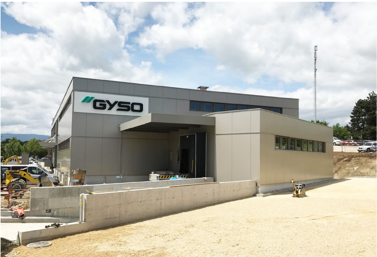
Filiale Crissier 2017- Umsetzung der Fassadenbekleidung mittels DOWSIL PanelFix System
