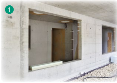
1 Untergrund auf Tragfähigkeit und Eignung prüfen
