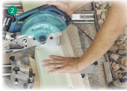
2 Systemwinkel auf gewünschtes Mass zuschneiden
