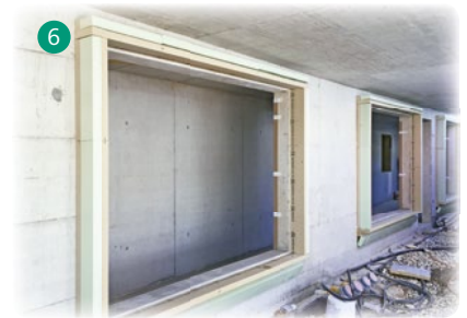
6 Ohne Wartezeit kann mit der Fenstermontage begonnen werden
