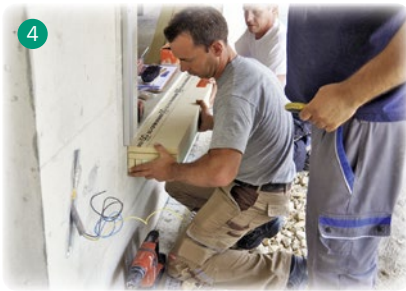
4 Erster Systemwinkel positionieren, anreiben und andrücken
