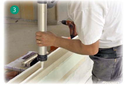
3 Systemkleber Polystrong 8966 zwei durchgehende Kleberaupen auftragen
