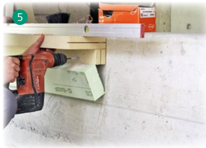
5 Zusätzlich Systemwinkel umlaufend mechanisch verschrauben
