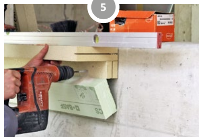
5 Zusätzlich Systemwinkel umlaufend mechanisch verschrauben
