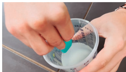
Abziehwerkzeug in Abglättmittel tauchen
