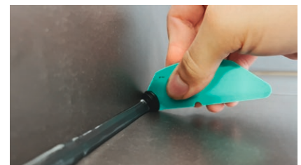
Dichtstoff abgeglättet (Glättmittel nicht mit einer Sprühflasche auftragen)
