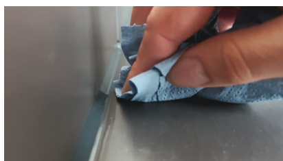
Überschüssiges Glättmittel direkt entfernen
