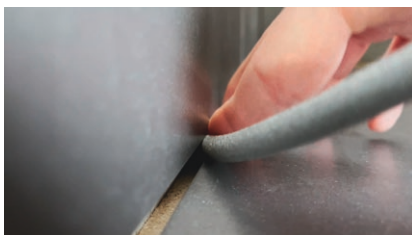
Fuge mit passender Rundschnur hinterfüllen
